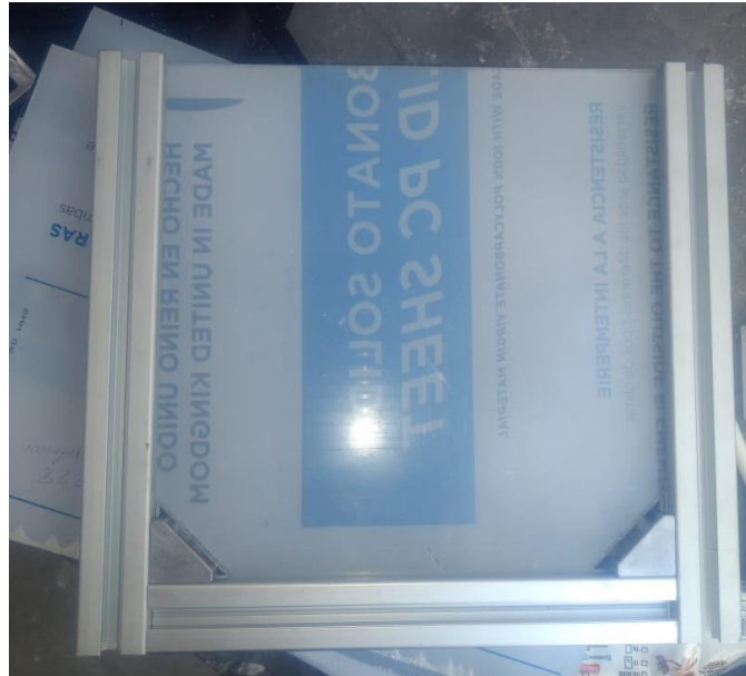
Figura 20 Cortes de policarbonato para las caras del contenedor. FUENTE: Elaboración Propia.
